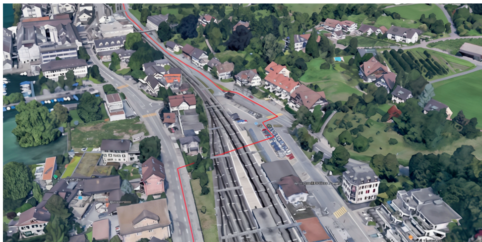
Abbildung 6: Gleisunterquerung Bahnhof Uetikon am See, Druckleitung im Pressbohrverfahren (Flugaufnahme)
