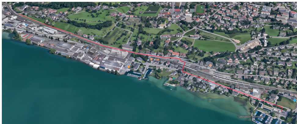
Abbildung 5: Linienführung Druckleitung (Flugaufnahme)
