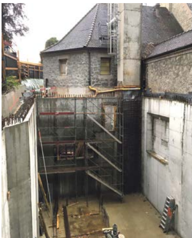
Die neue Rauchgasreinigungsanlage befindet sich in einem separaten, unterirdischen Gebäude.
