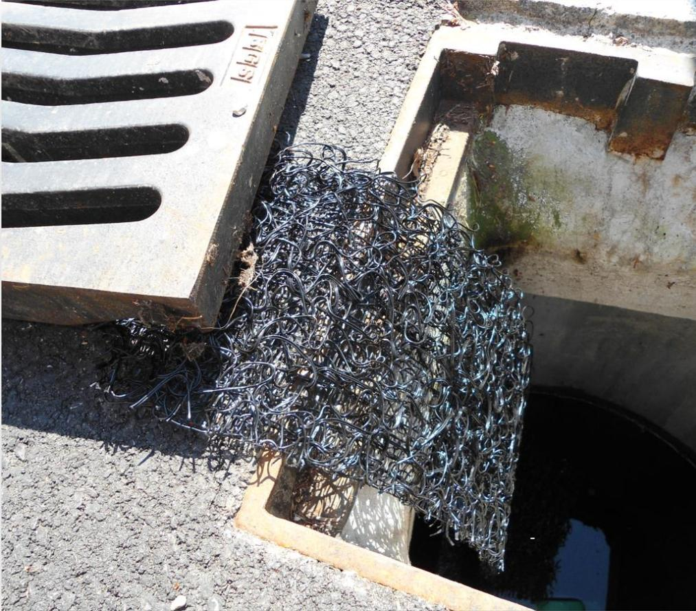
Bild: Ausstiegshilfen für Amphibien welche an 180 Dohlendeckeln von Entwässerungsschächten angebracht wurde.
